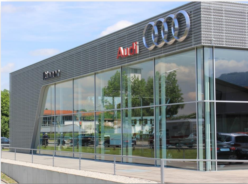
Neubau eines Audi-Terminals in Bad Tölz
